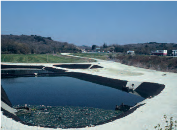
Bassin de réception des eaux de pluie, au bord de l'autoroute du Jura.
