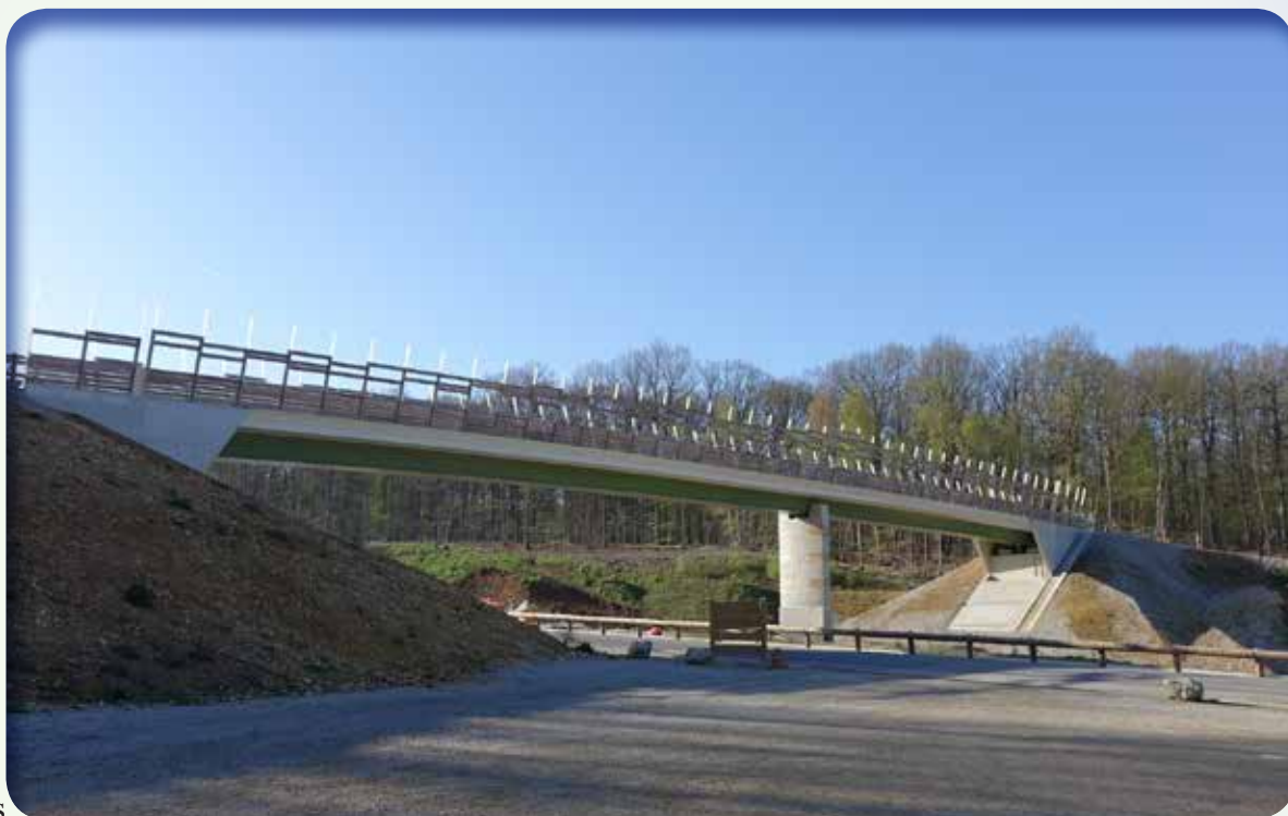
Passerelle en cours d'achèvement et son parking,
